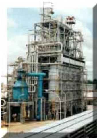
Reactor de Reformado de gas natural con vapor
